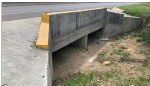
Box Culvert 1: Alcantarilla Rectangular de doble ventana. Cada ventana tiene un ancho de 3.10 m x 1.0 m de alto
