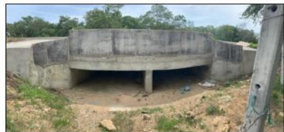
Box Culvert 1: Alcantarilla Rectangular de doble ventana. Cada ventana tiene un ancho de 3.10 m x 1.0 m de alto
